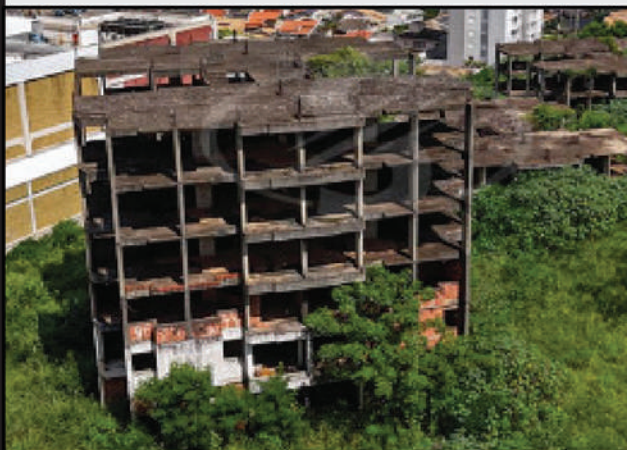
EDIFÍCIO COM 10.571 M² EM CAMPINAS/SP
