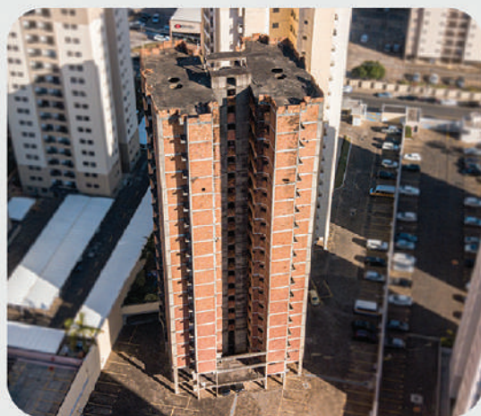
Edifício inacabado em Campinas/SP
