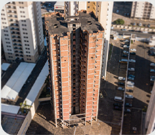
Edifício inacabado em Campinas/SP
